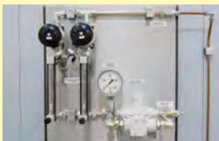
Sistema de gasificación para gases protectores o reactivos no inflamables
